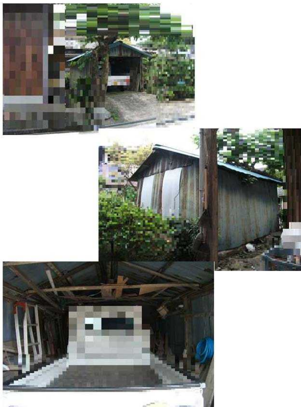
基礎、屋根、壁等がある木造車庫
