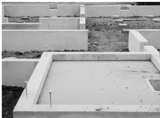
【土間コンクリート打設後の現場】
