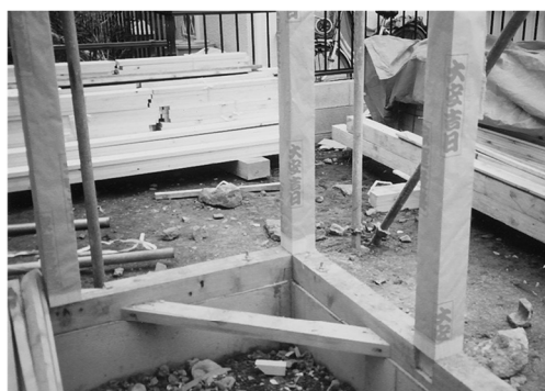
【下層横架材(土台・火打土台)】
