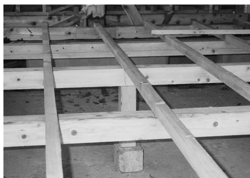
【大引・根太の施工現場】
