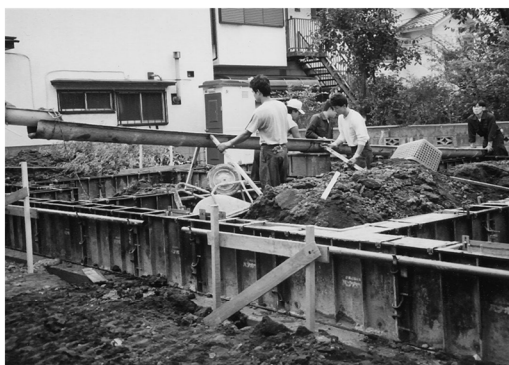
【布基礎コンクリート打設の現場】
