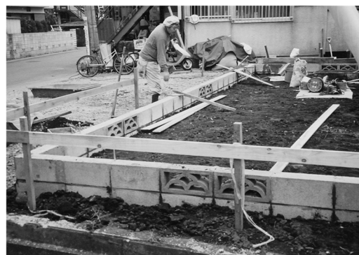
【空洞ブロック積の現場】
