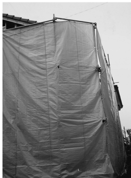
【仮設防災防止シート張現場】
