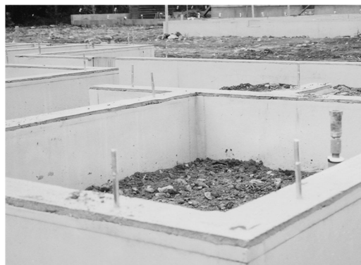
【布基礎天端モルタル均し後の現場】
